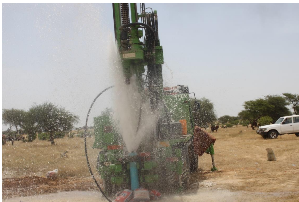
Photo : Forage productif au niveau du site de waragou (commune de Gueskerou)
