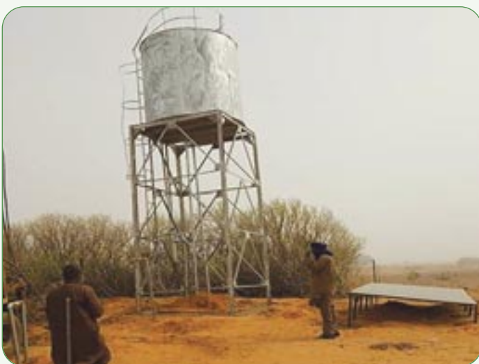
Tronçon Badaguichiri - Kolkoli réalisation d'une Mini adduction d'eau solaire à Kolkoli
