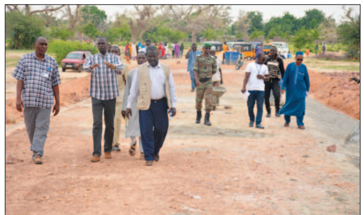
Etape de Maradi, chantier piste rurale tessaoua -oura dan Saga
