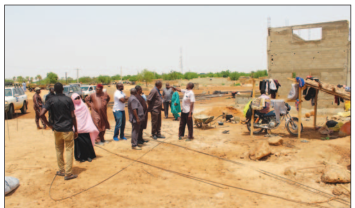
Etape de Zinder, chantier marché de demi-gros Mirriah
