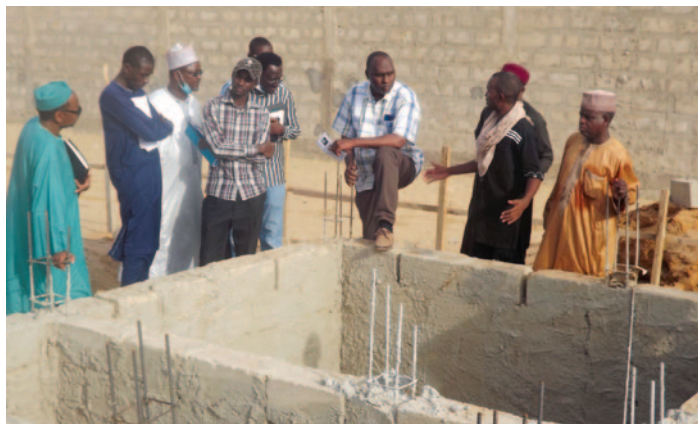
Chantier du marché demi gros de la commune de Diffa
